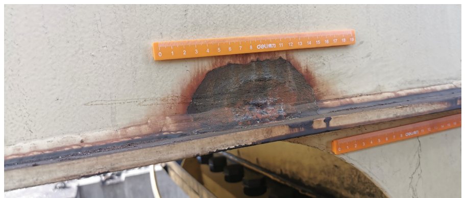
Рис. 3. Магнитные линейки в качестве шаблонов на балке портала контейнерного перегружателя KONE
