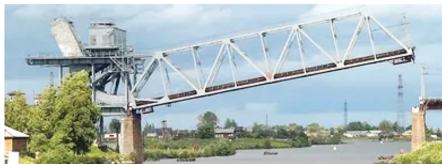
Рис. 4. Шиженский железнодорожный мост откатно-раскрывающийся
