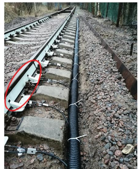
Рис. 7. Фото измерительных рельсов с установленными защитными кожухами
