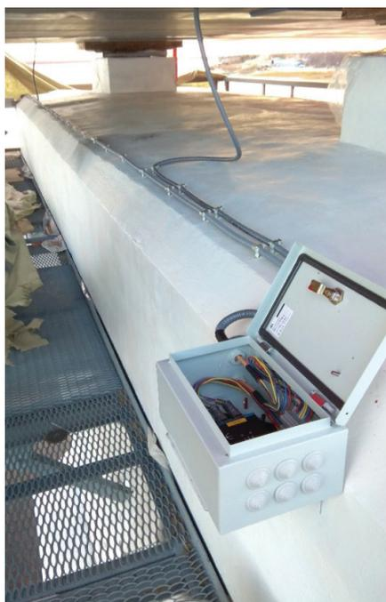
Рис. 4. Смонтированные инклинометры на объекте мониторинга
