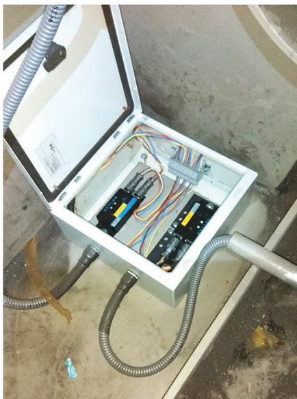
Рис. 2. Смонтированные акселерометры на объекте мониторинга
