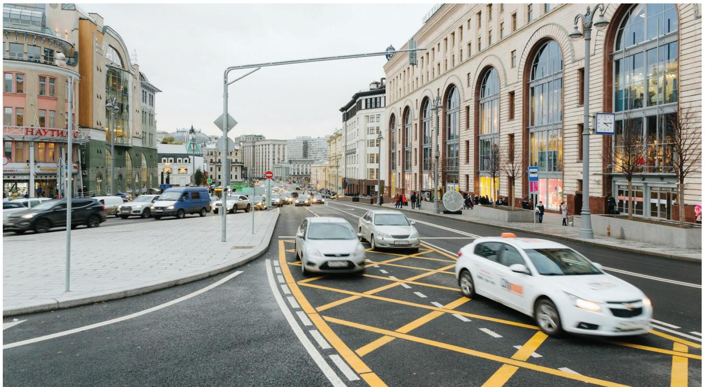
Рис. 4. Применение на пересечениях горизонтальной разметки 1.26 по траектории движения общественного транспорта для обеспечения его беспрепятственного проезда
