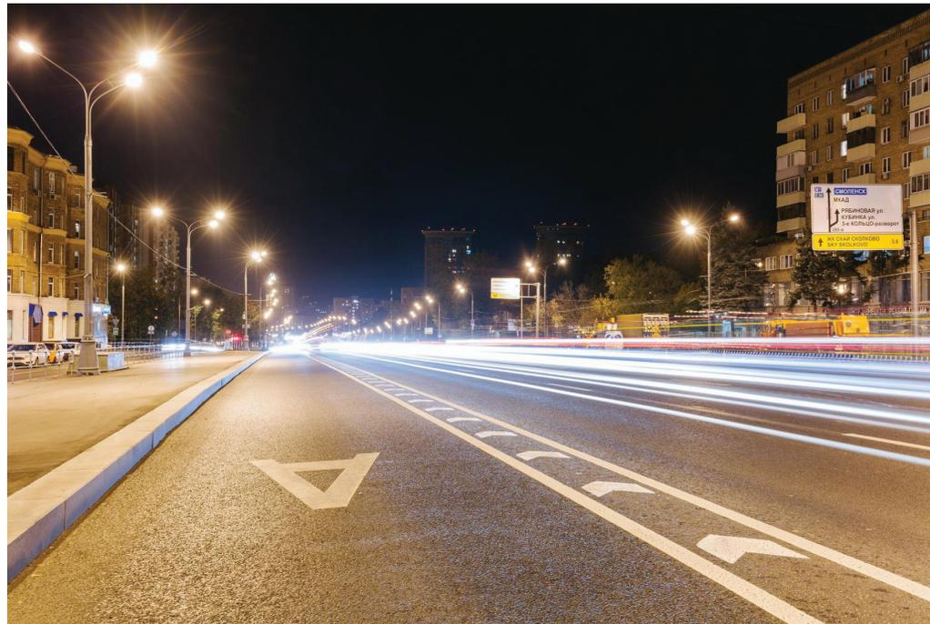
Рис. 2. Применение горизонтальной разметки 1.16.2 для отделения выделенной полосы от полос общего пользования
