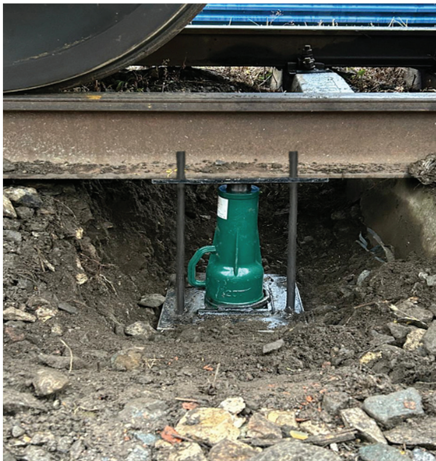
Рис. 4. Прототип подрельсового основания с переменной жесткостью
