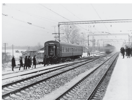
Рис. 8. Испытания стрелочного перевода, разработанного ПКБ Главного управления пути МПС и ЛИИЖТ с подвижным сердечником крестовины на станции Померанье Октябрьской железной дороги. Проход на скорости 228 км/ч. 26 февраля 1971 г. [10]
