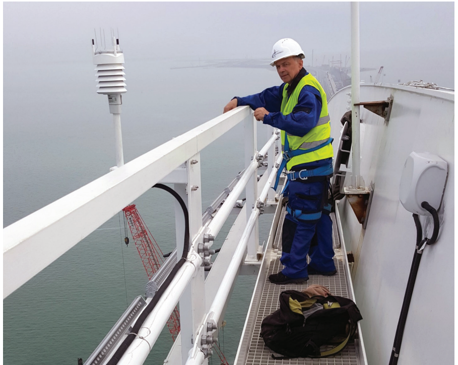
Рис. 5. Обслуживание метеостанции на арке автодорожного моста
